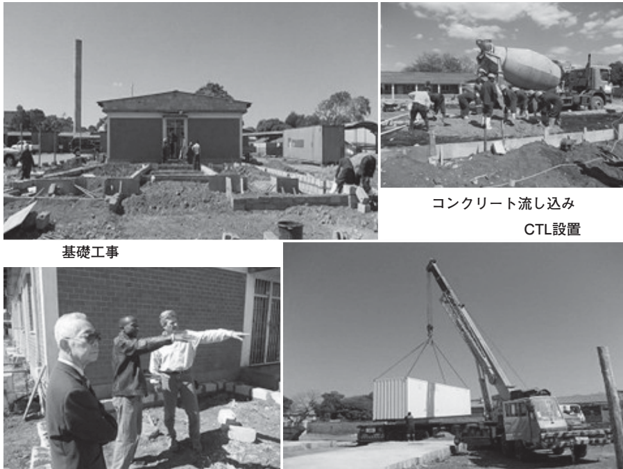
図 4 UTH の結核研究検査室に増設される BSL3 の CTL 設置工事
